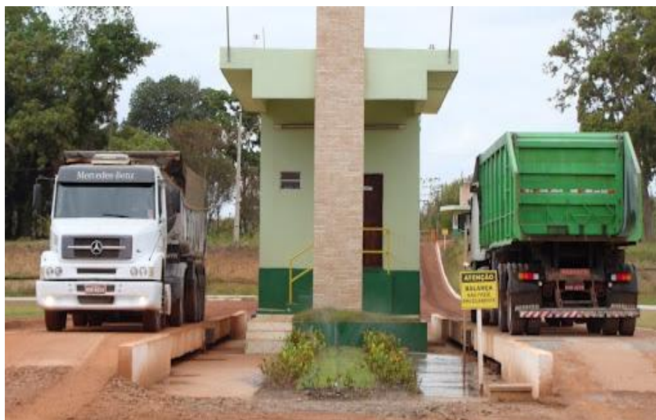
Figura 36: Aterro Sanitário Titara
